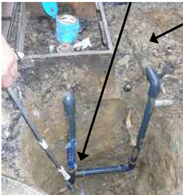
先端以下は地下に埋められ、送水・停水を管理していたと見られるバルブ
