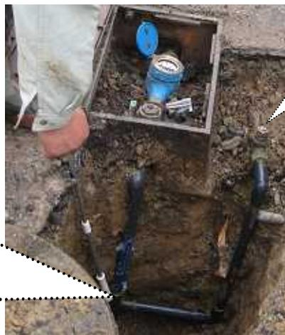
掘削調査にて盗水用のバイパス管を確認。職員がさしているのは「ティーズ」と呼ばれる管を分岐する接続部品
