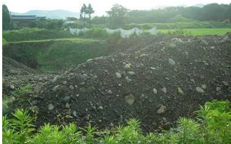
小川原・犬上川堤防を望む田堀起こし現場
